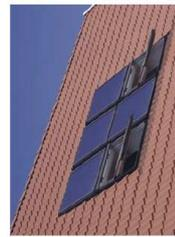
Quatre modules de capteurs thermiques et deux fenêtres de toit constituent un ensemble. © IELVA
