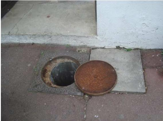
Lors de l'injection de la fumée dans le réseau, les deux boîtes de branchement du restaurant se sont mises à fumer. Il est donc préconisé de vérifier les installations de ce restaurant.
