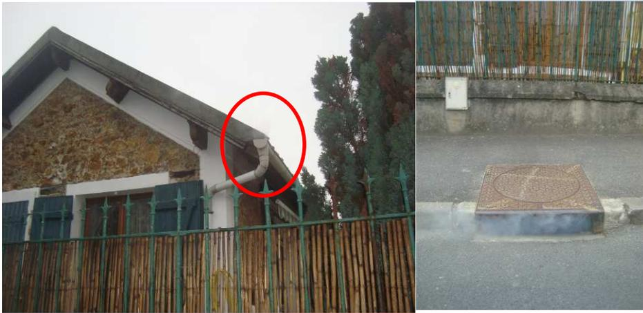
La gouttière du n°8 rue des Ecoles est raccordée sur le réseau public d'eaux usées.
