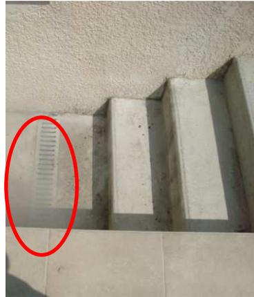
Une gouttière et une grille sont raccordées au réseau public d'eaux usées.
