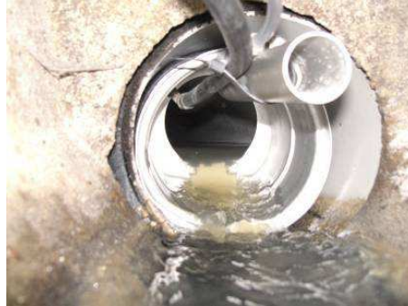
Manchon déversoir installé dans un collecteur
